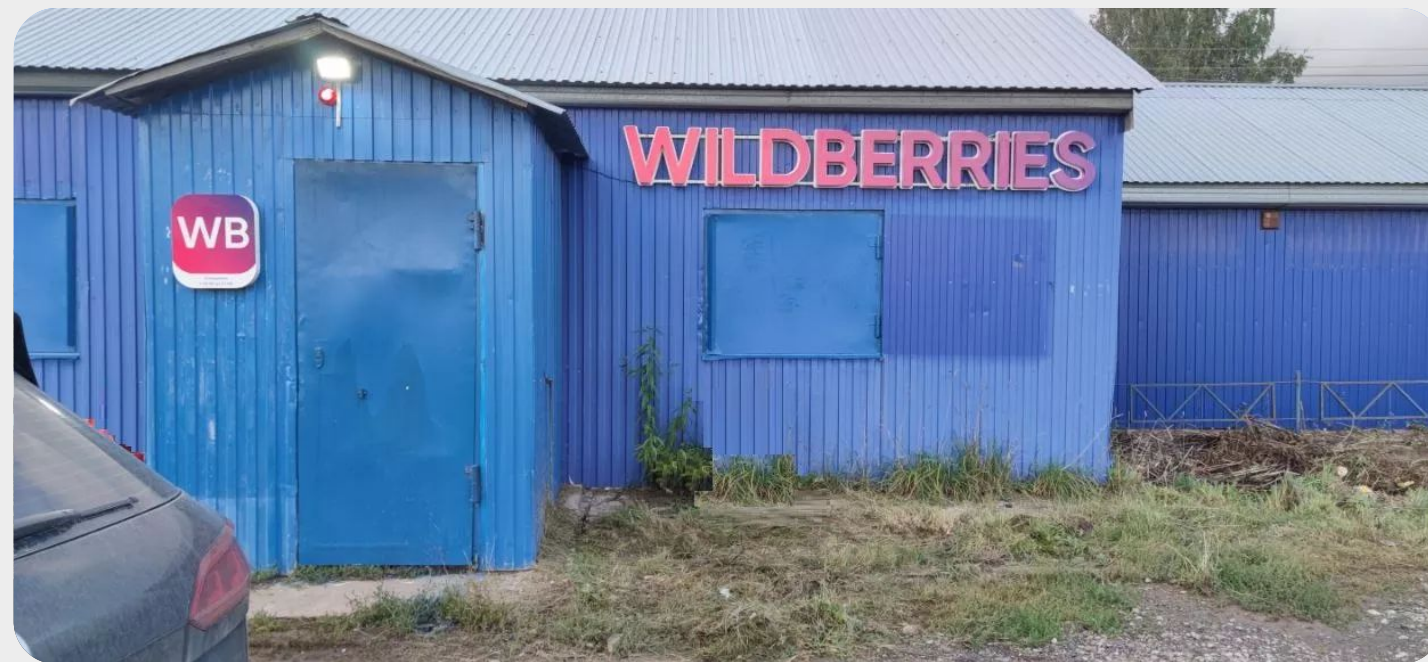
В здании с фасадом в плохом состоянии
